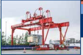
Schwergut-Umschlagplatz mit Ro-Ro-Rampe und Litzenhubsystem
